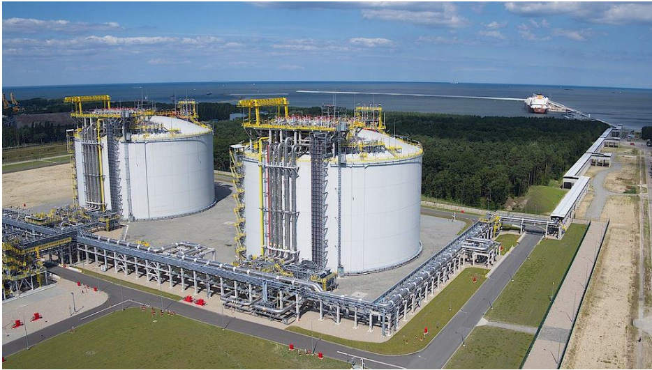
Świnoujście LNG terminal Polskie LNG @ Felinski-Piotr
